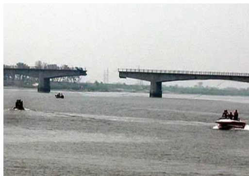
图 1.2 盘锦田庄台大桥垮塌事故
