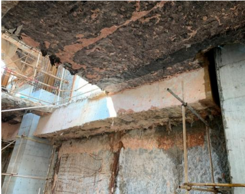
图 5.2.3-4 腰梁与结构柱冲突处设置开口
