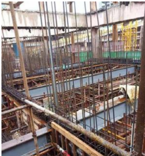
图 5.2.2-2 内支撑封板拆除
