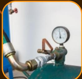
使用过程中，应定期检查储气罐的压力、温度等参数，确保正常。
