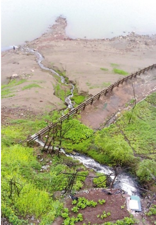
鹅公岩桥下生活污水直排长江
