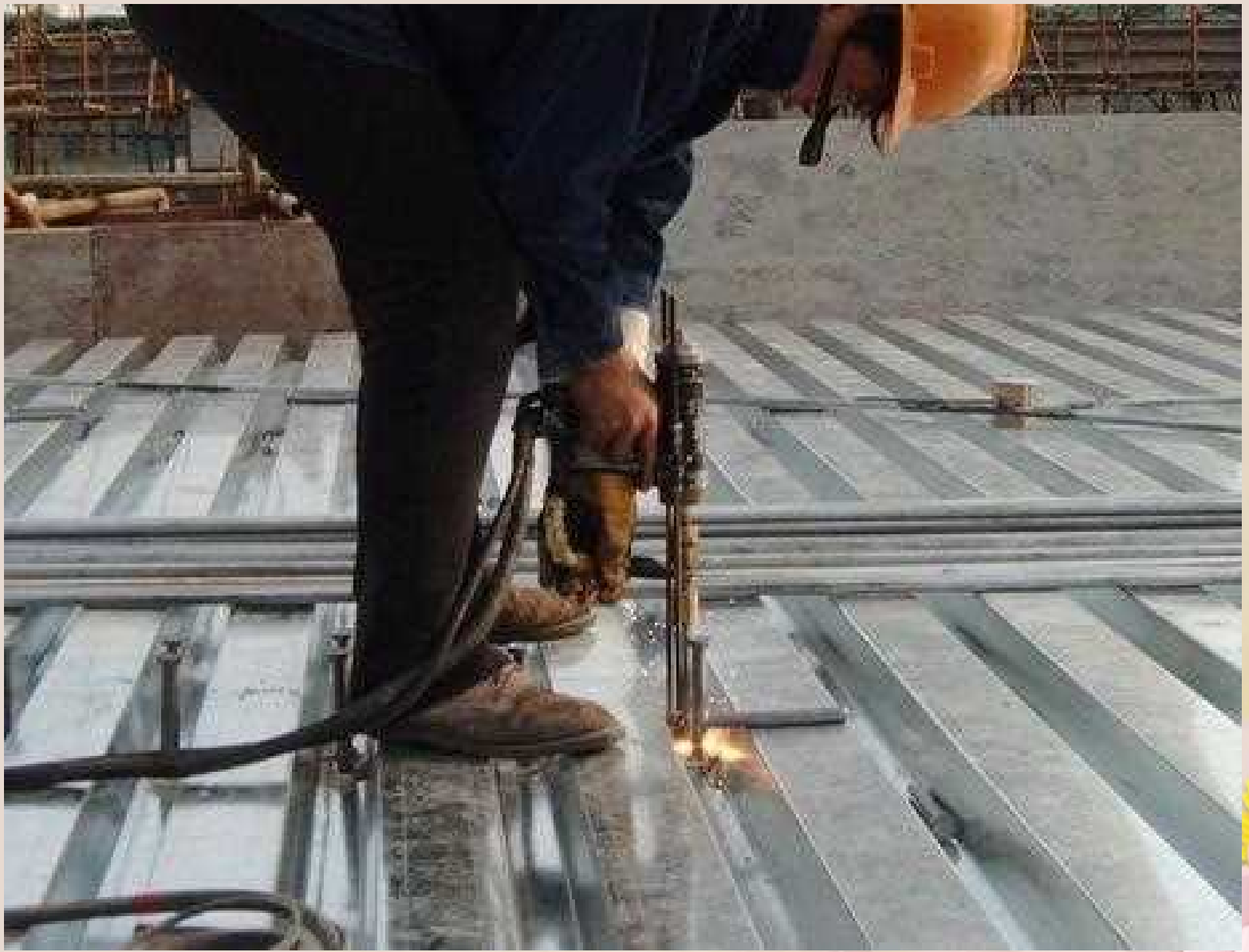
栓钉焊接施工 组合结构第四章钢-混凝土组合梁
