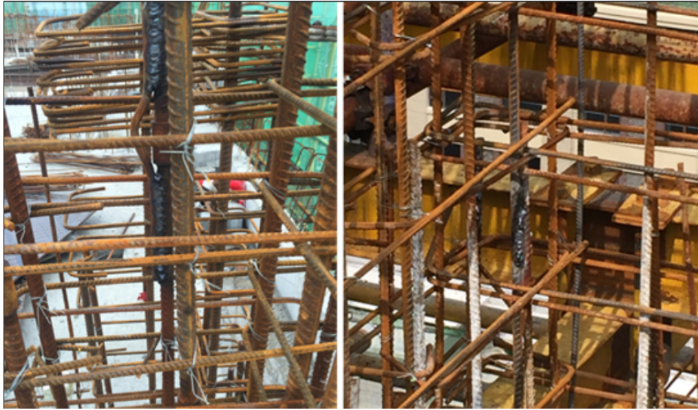
图 4.1-11 防雷引下线焊接
