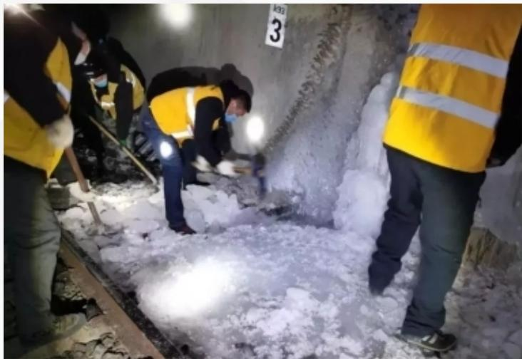
隧道冻害：冬季隧道侧壁及拱顶排水管结冰堵塞，水渗出结冰，图为除冰作业
