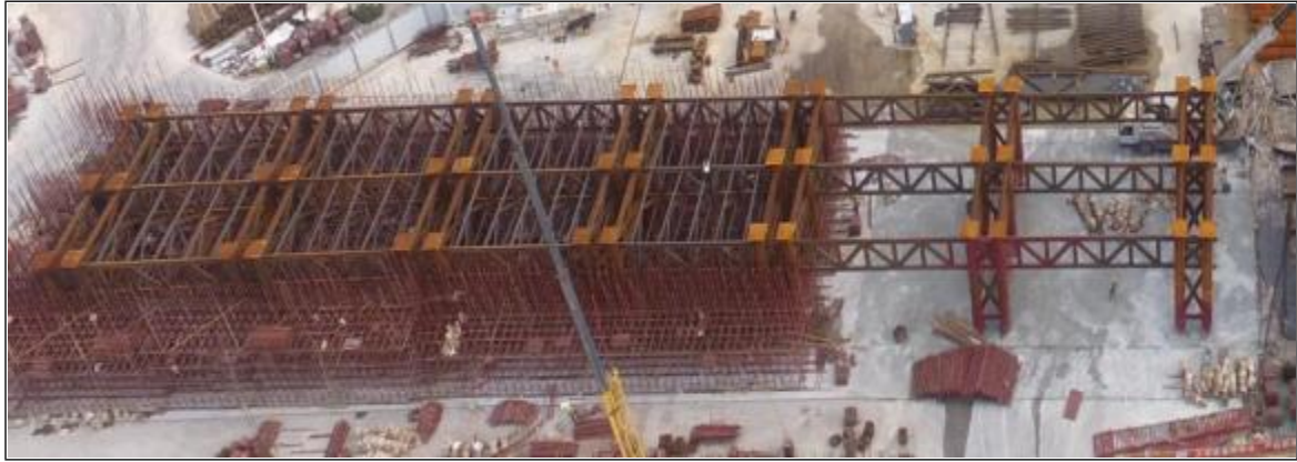
5. 2. 2-3 串联桁架布置图
