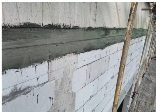
图 5.2.3 基层弹线图
