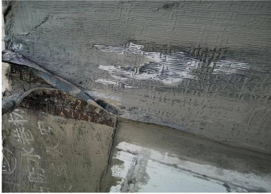
图 5.2.5-3 防水卷材竖向搭接图
