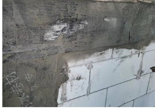
图 5.2.5-4 防水卷材横向搭接图
