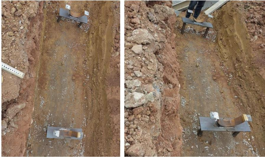
图 5.2.4-2 预制支撑安装
