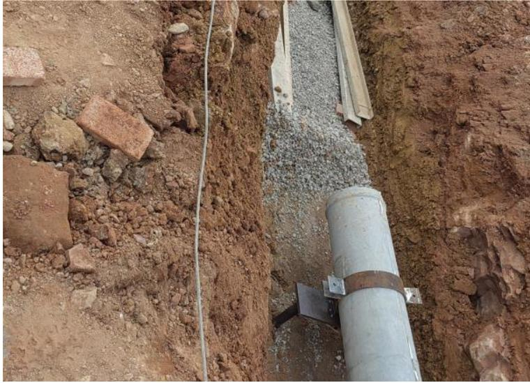
图 5.2.6 砂砾石分层回填
