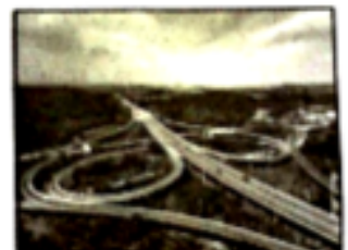
D. 修立交桥
