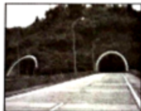
B. 开凿隧道
