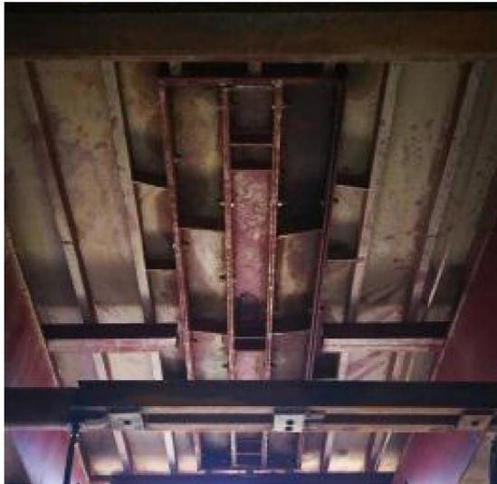
图 5-8 独立骨架支撑系统安装
