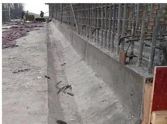
图 5-3 底板、导墙及排水沟成型
