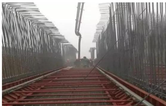
图 5-1 底板及导墙混凝土浇筑
