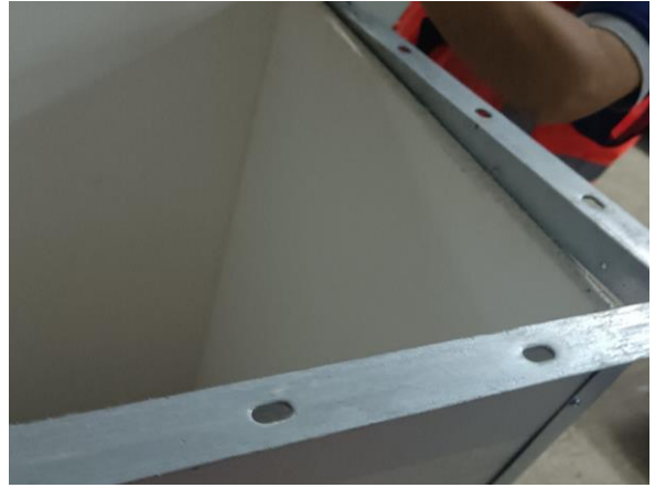
图 5.2.2-10 成品法兰端口套接
