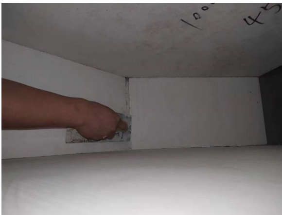
图 5.2.2-13 风管折角专用胶填塞密封
