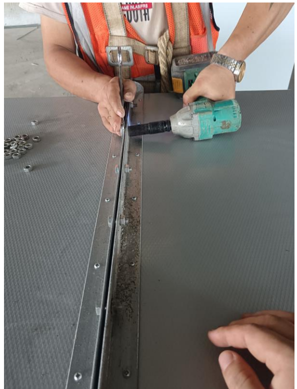
图 5.2.2-12 螺栓紧固
