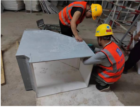
图 5.2.2-8 风管整体拼装加固
