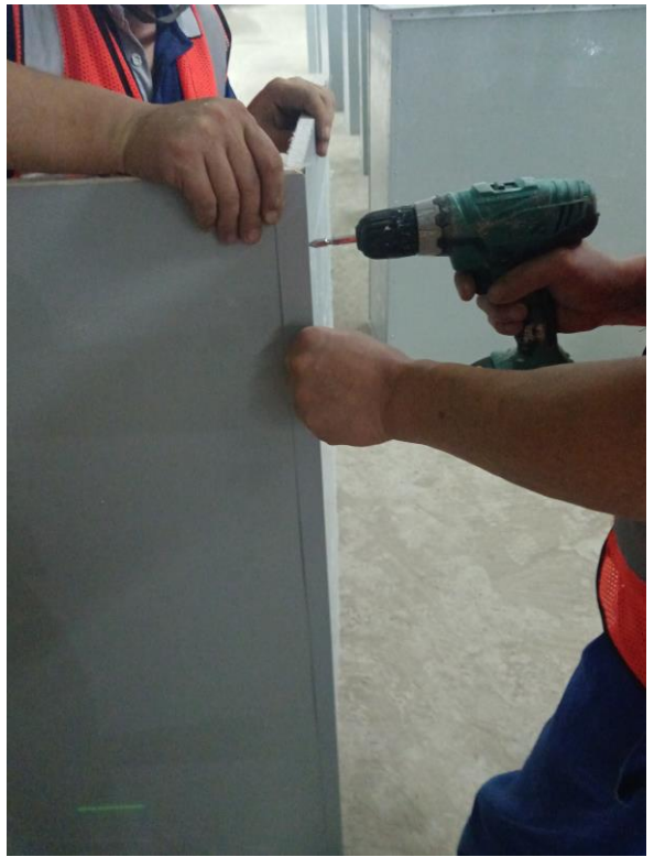
图 5.2.2-8 自攻螺丝固定拼缝
