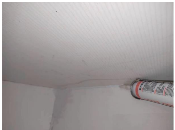
图 5.2.2-14 拼接缝打胶密封
