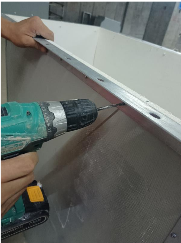
图 5.2.2-11 法兰、风管螺栓钻孔
