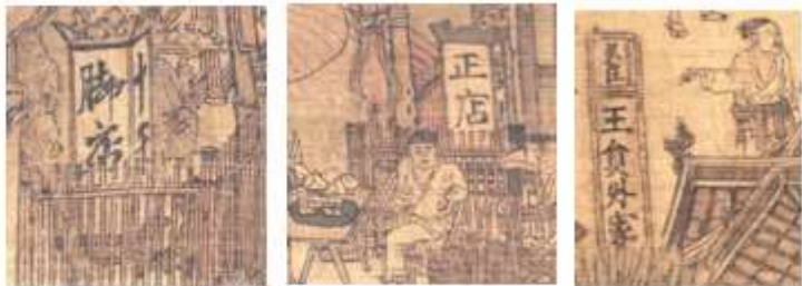
图二《清明上河图》中的招牌、灯箱等广告。全图中有 10面幌子，23块招牌，至少4个灯箱，5座欢门彩楼
