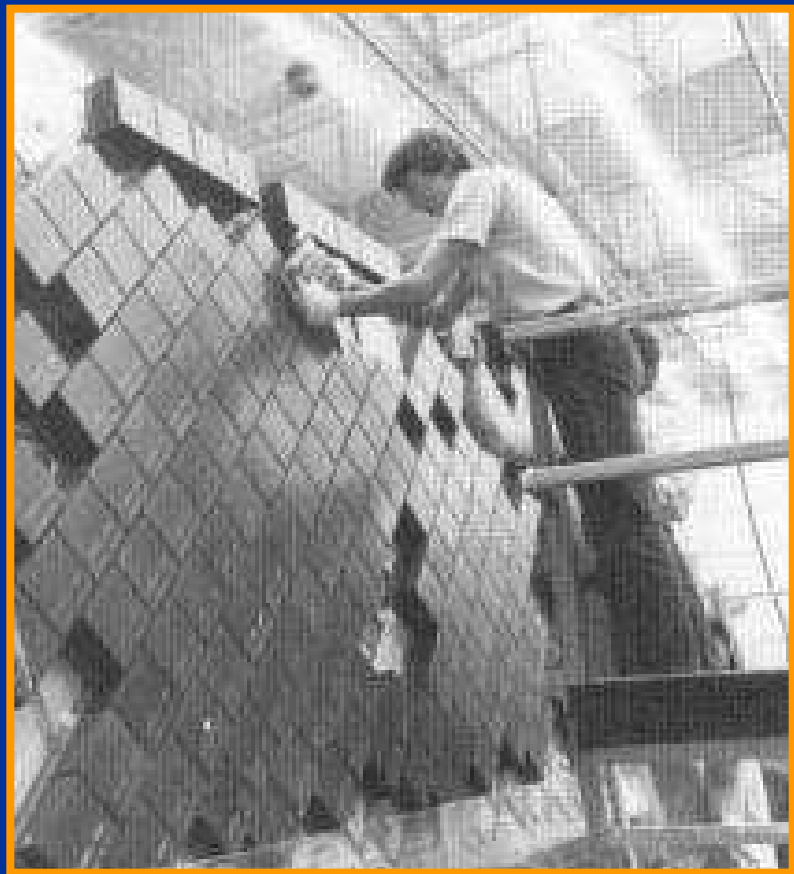
在航天飞机表面装陶瓷防护瓦片
