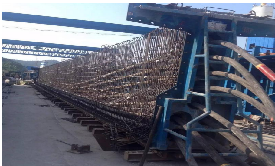
图 5.2.1-1 混凝土梁的制作
