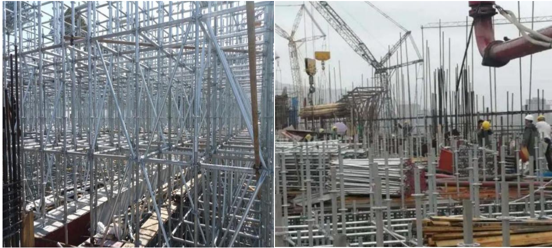
图 4-1 高密度大跨度预应力梁超高承插式盘扣支模架
