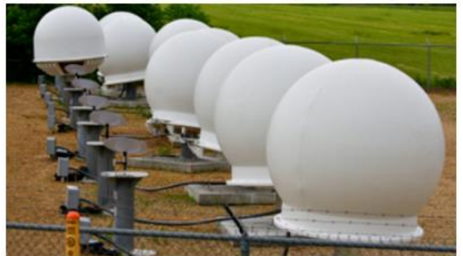
图23：Starlink 地面关口站
