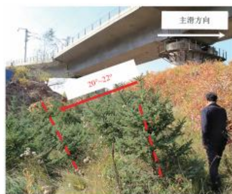
(b) 坡面及树木倾斜 20^\circ \sim 22^\circ
