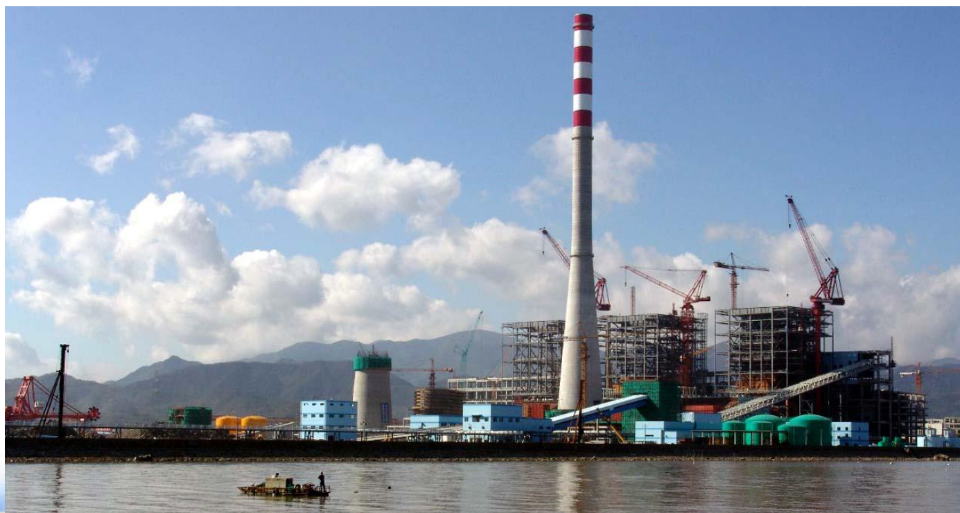
乌沙山火电厂 施工全景
