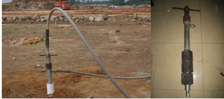
孔口管动态阻塞法实行照片和止浆阀结构示意图
