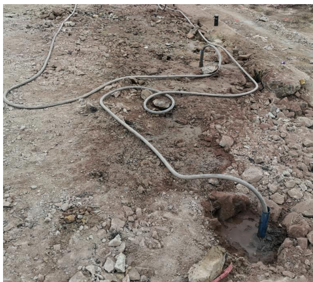
图 5.2.2-4 孔口封闭注浆法
