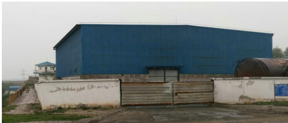
拟改造为大修渣库的库房
