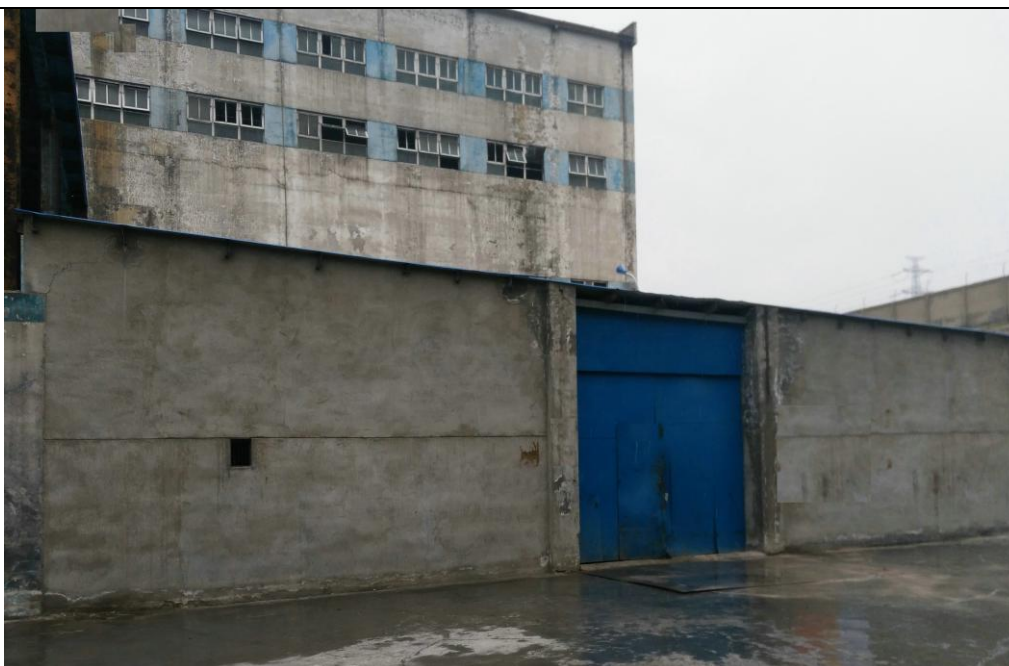
拟改造为废焦油库的库房
