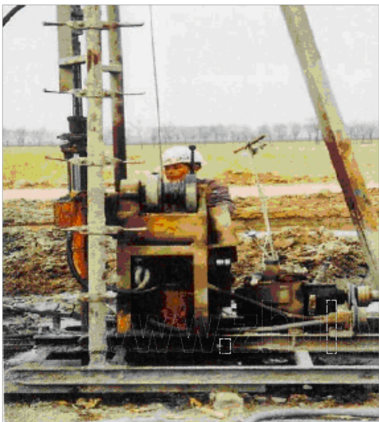
图 7 单重管法旋喷桩施工照片
