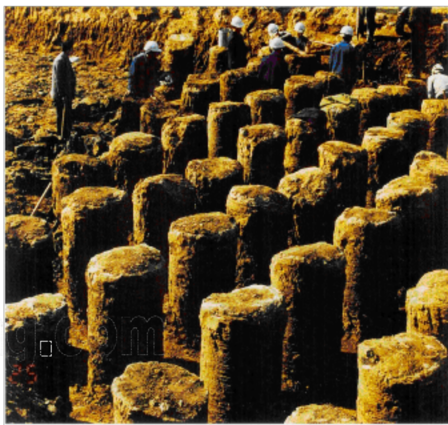
图 8 旋喷桩施工效果照片
