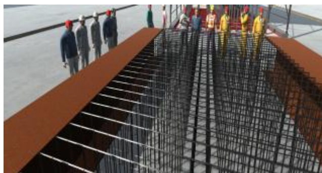
图 5.2.3-13 钢筋笼验收示意图
