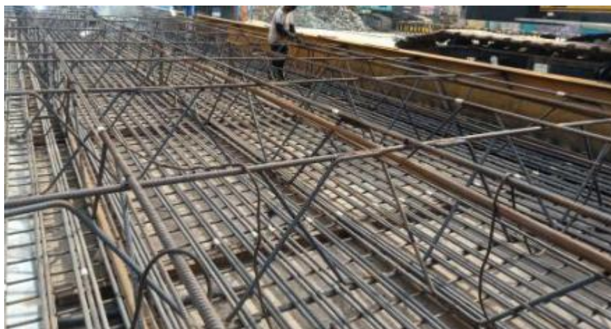
图 5.2.3-12 主钢筋笼现场制作
