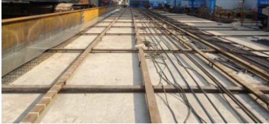
图 5.2.3-3 钢筋笼加工平台现场图
