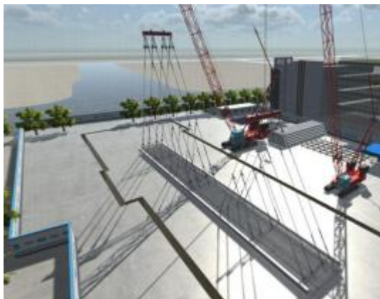
图 5.2.5-1 钢筋笼主笼试吊图
