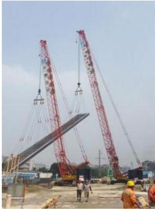
图 5.2.5-4 钢筋笼主笼双机台吊图
