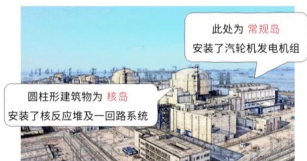
图21. 采用华龙一号技术的福清核电 5、6 号机组
