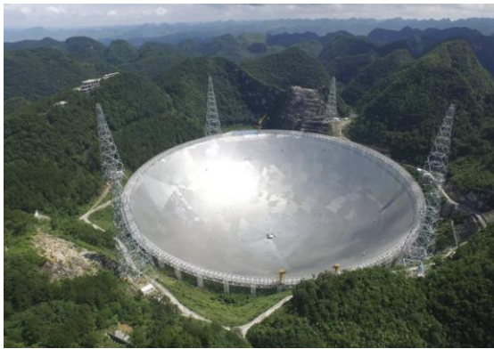
图 5 54 所承担了 500 米天线两大核心系统的研制工作：馈源舱及舱停靠平台、反射面单元系统
