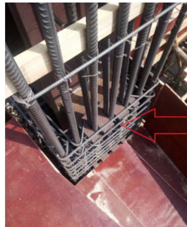
图 5.1-6 型钢柱连接板开孔设置
