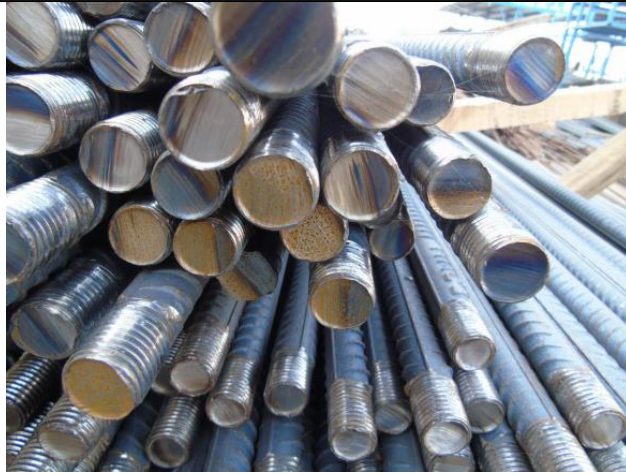
图 5.1-1 钢筋套丝丝头质量
