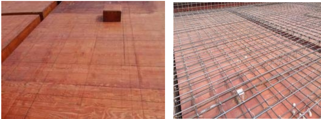
图 5.1-3 模板弹线、钢筋绑扎
