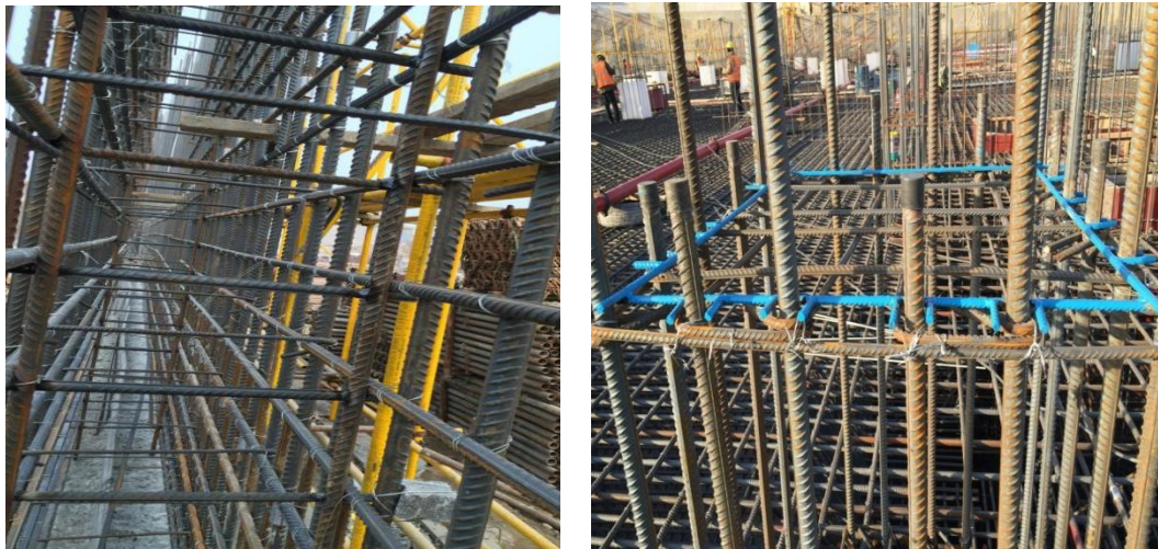
图 5.1-2 墙柱钢筋的定位措施
