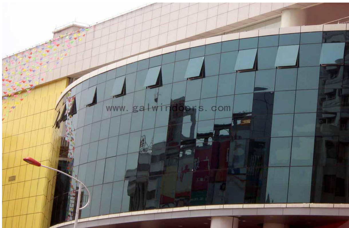
全隐框玻璃幕墙
