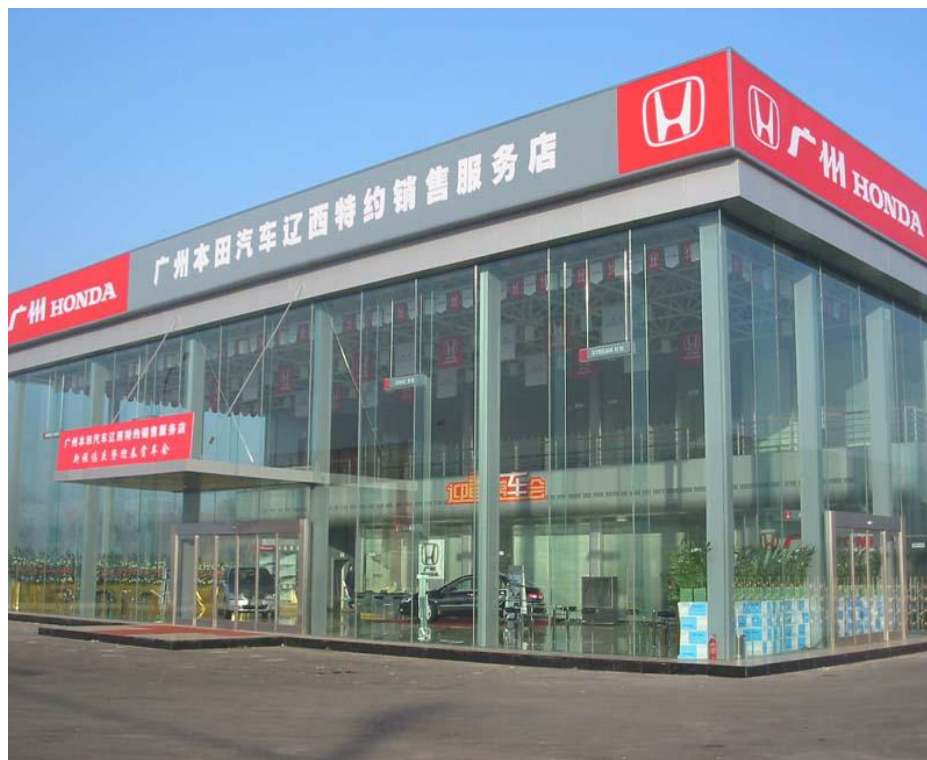
吊挂式无骨架玻璃幕墙
