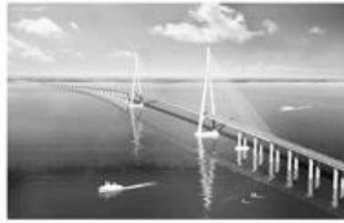
杭州湾跨海大桥
