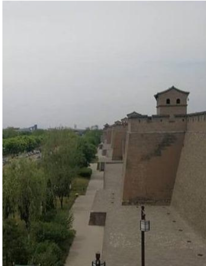
平遥古城的外墙面及马面、敌台
