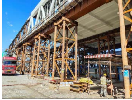
a.杭州火车南站拼装平台
