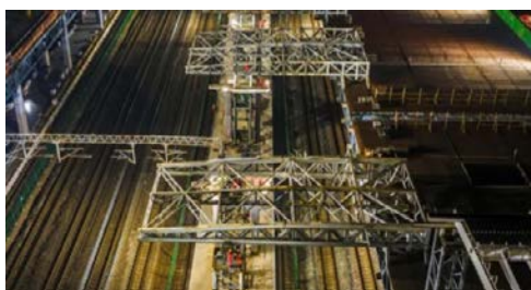
图 5.2.5-3 “L”型导梁实景图
