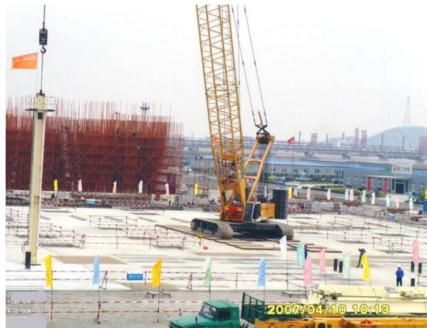
交付钢结构安装的场地
