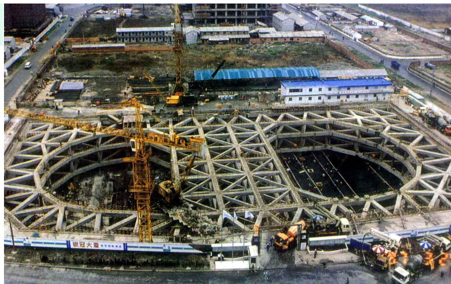
银冠大厦深基坑支护工程
