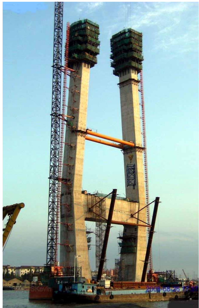
高桥墩爬山模施工
