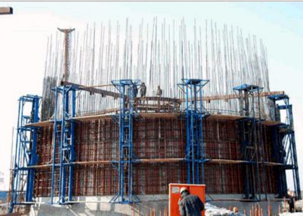
烟囱液压滑模施工
