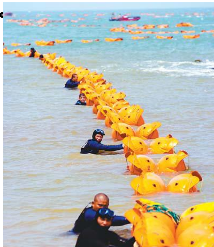
跨海海底电缆上岸—海南
