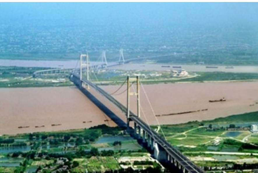
江苏润扬长江大桥南汊桥
