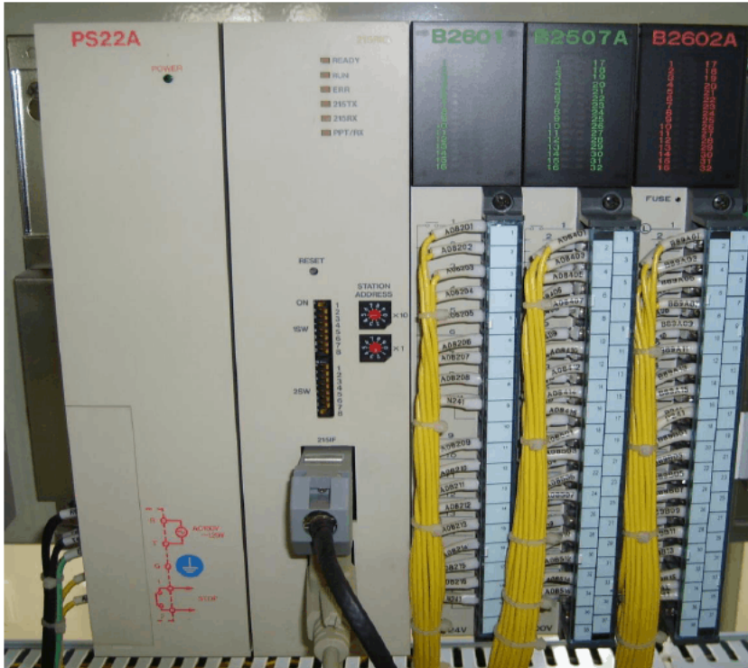
图 5 从左至右依次为安川 PLC 电源模块、215R10 模块、直流 24V 输入模块、交流 220V 输入模块及直流 24V 输出模块
