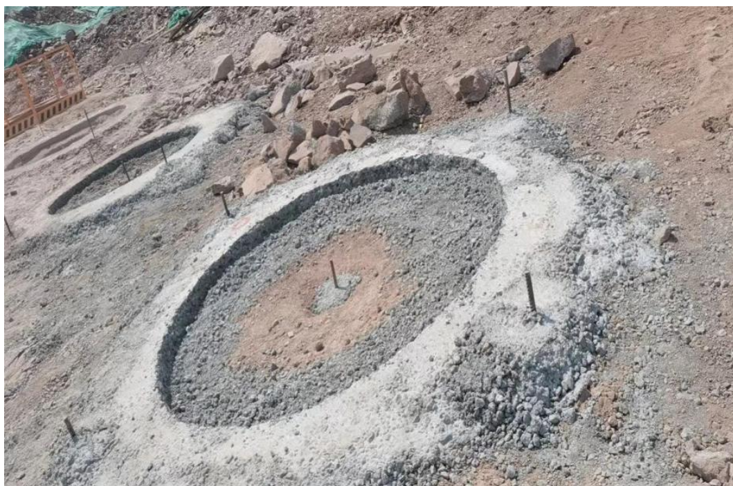
图 5.2-5 护壁加固
