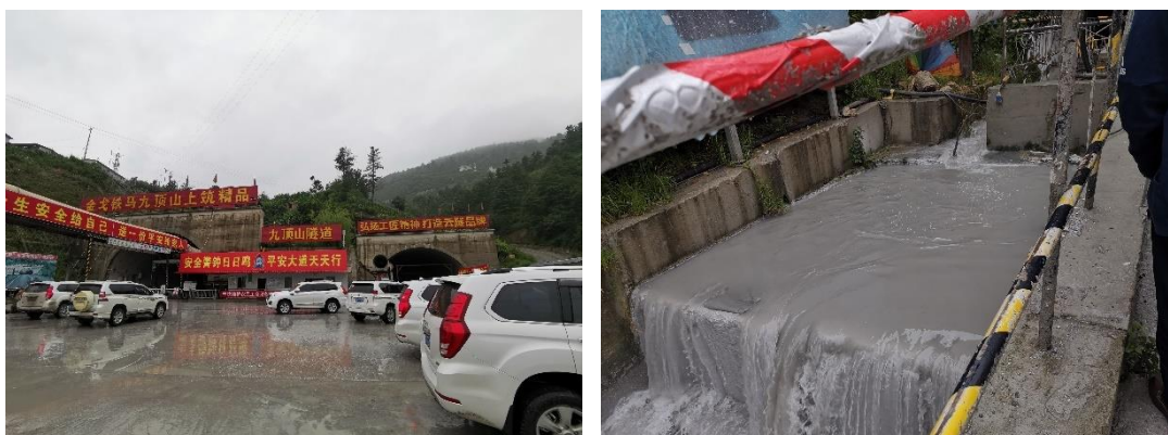
图 3-4 编写工作组前往云南楚大高速九顶山隧道现场考察防排水施工情况
