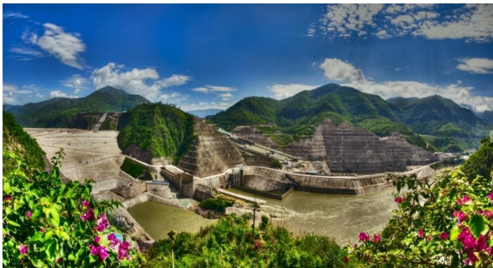
图11 坝式水电站示例——糯扎渡水电站
