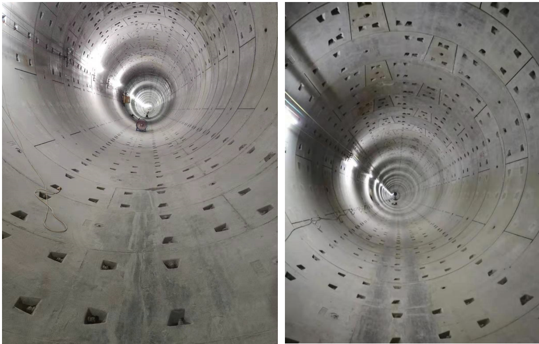
图 4、区间左线 401-1740 环现状
