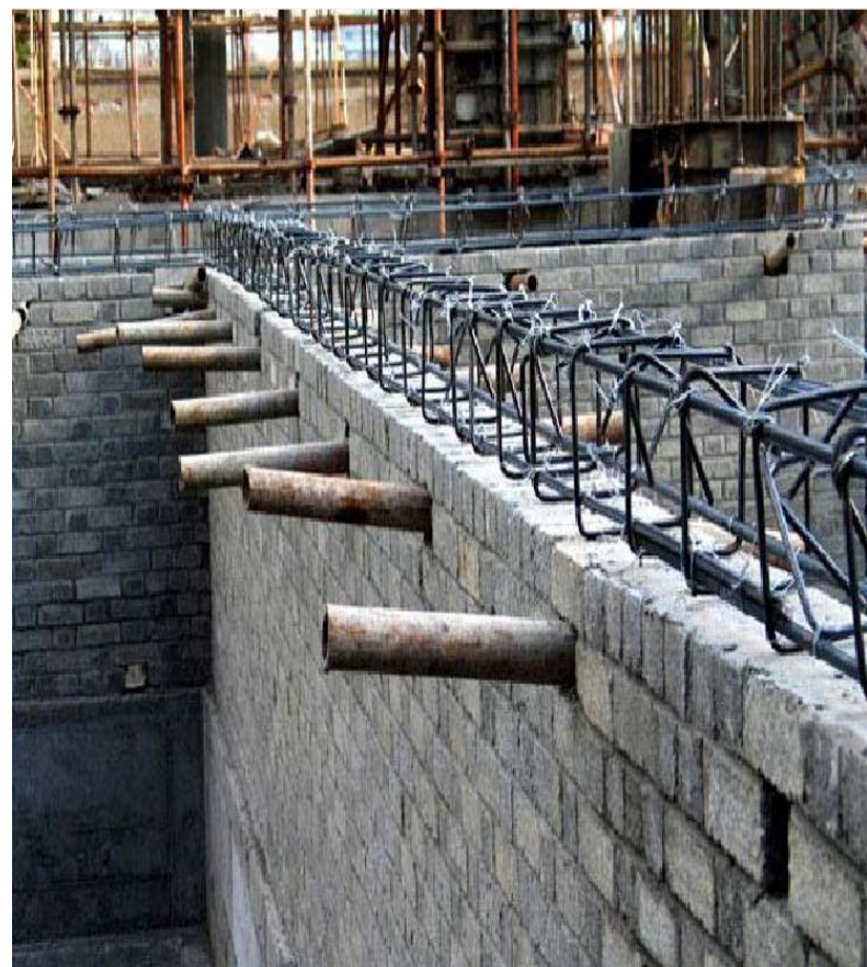
墙顶的整砖丁砌
