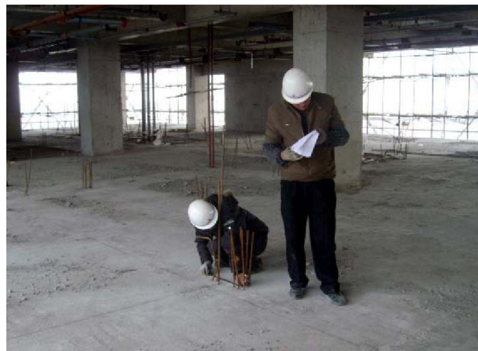
楼层围护墙的墙身放线
