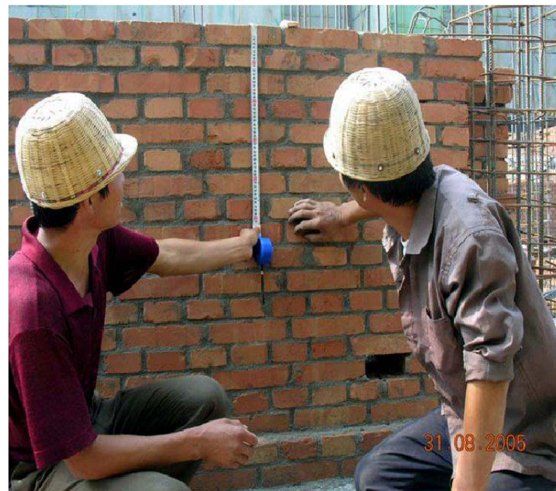
质检员进行灰缝厚度检验
