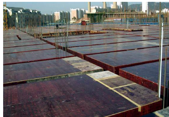
竹胶合板模板铺设楼面
