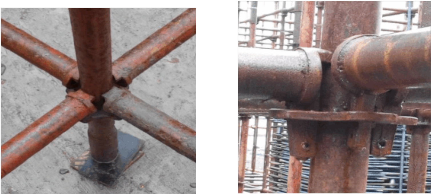
插扣式脚手架立杆连接轮盘
