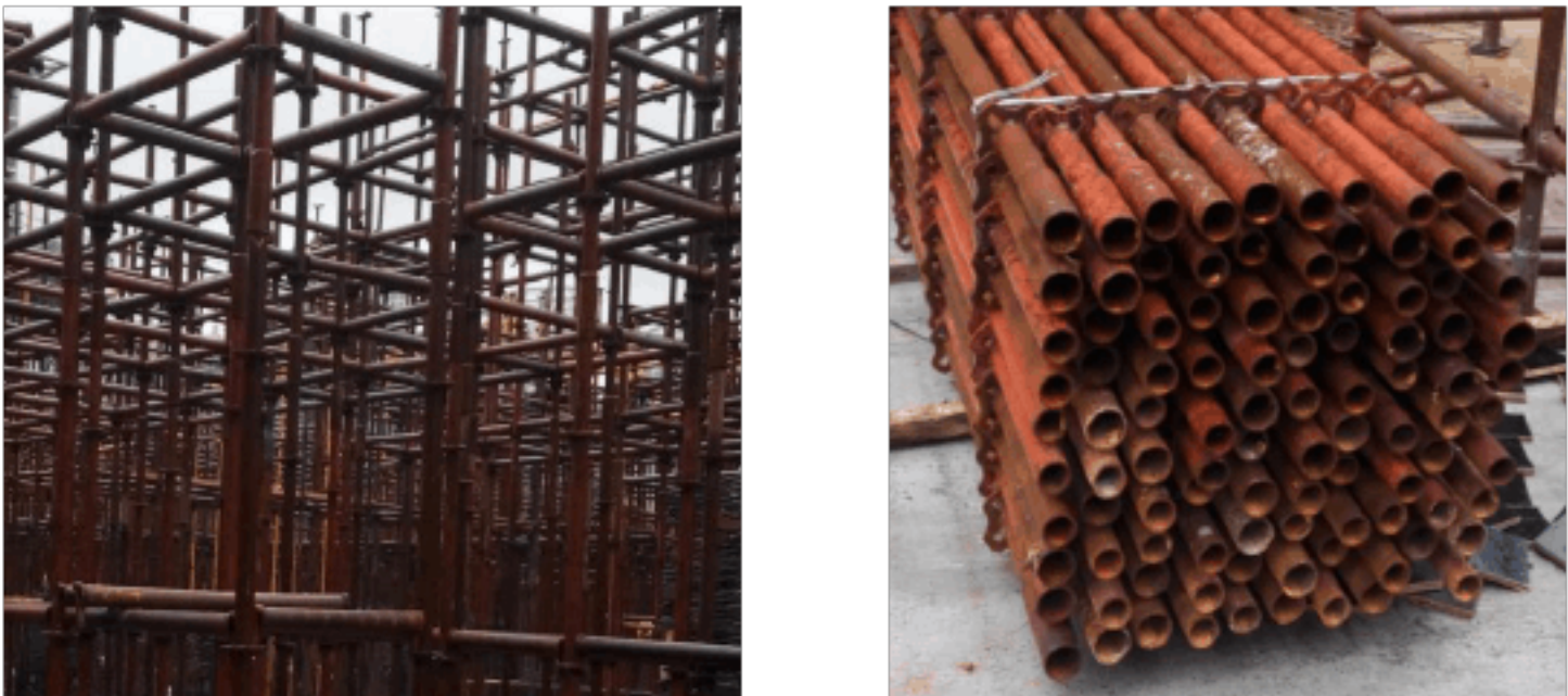
插扣式脚手架立杆连接套管
