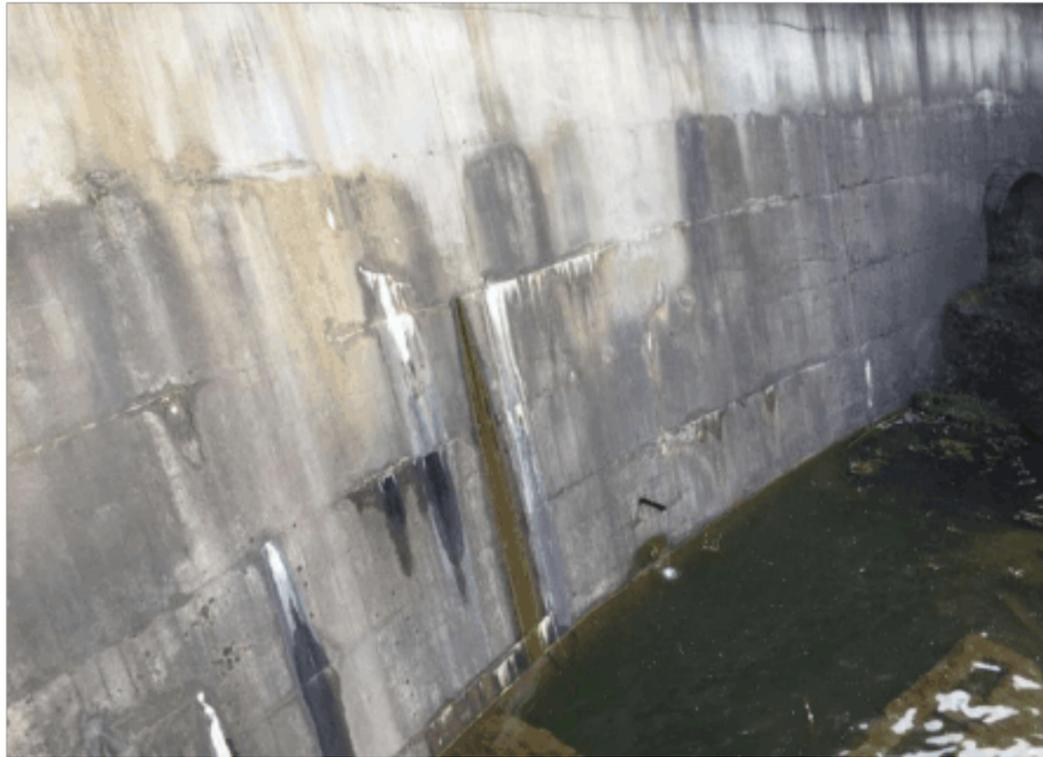
(2) 坝面完好平整，未发现裂缝、错动、沉陷；相邻坝段之间无错动，伸缩缝开合状况良好。
