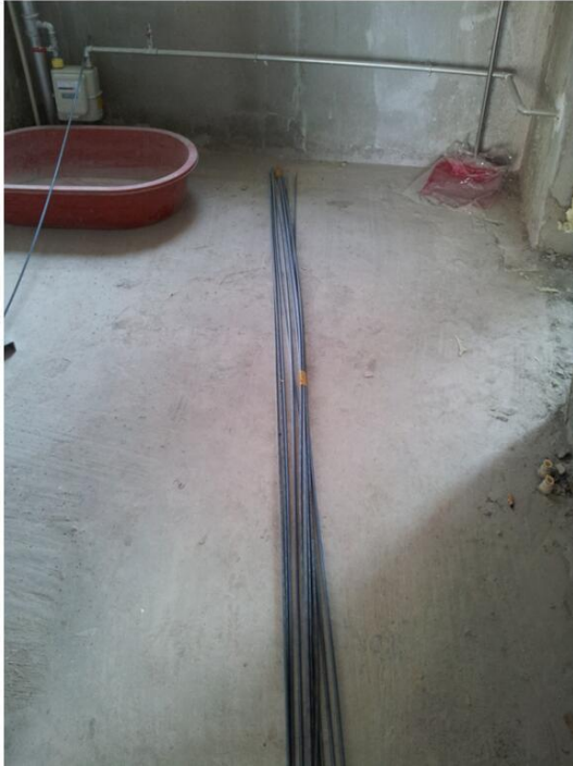
轻体墙用到的钢筋
