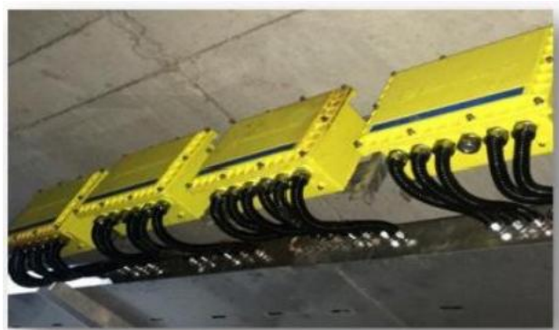
图 1 7ACU 安装现场
