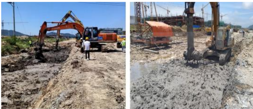
图 5.2.6-6 沟槽搅喷固结分区施工示意图
