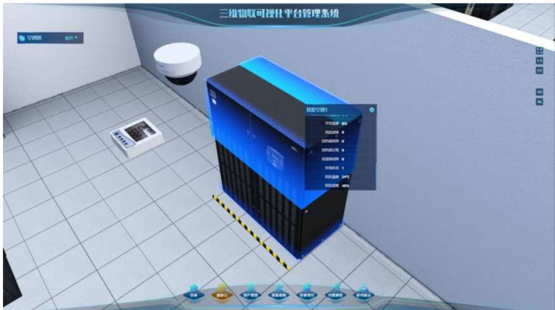
(精密空调实时监控数据)
