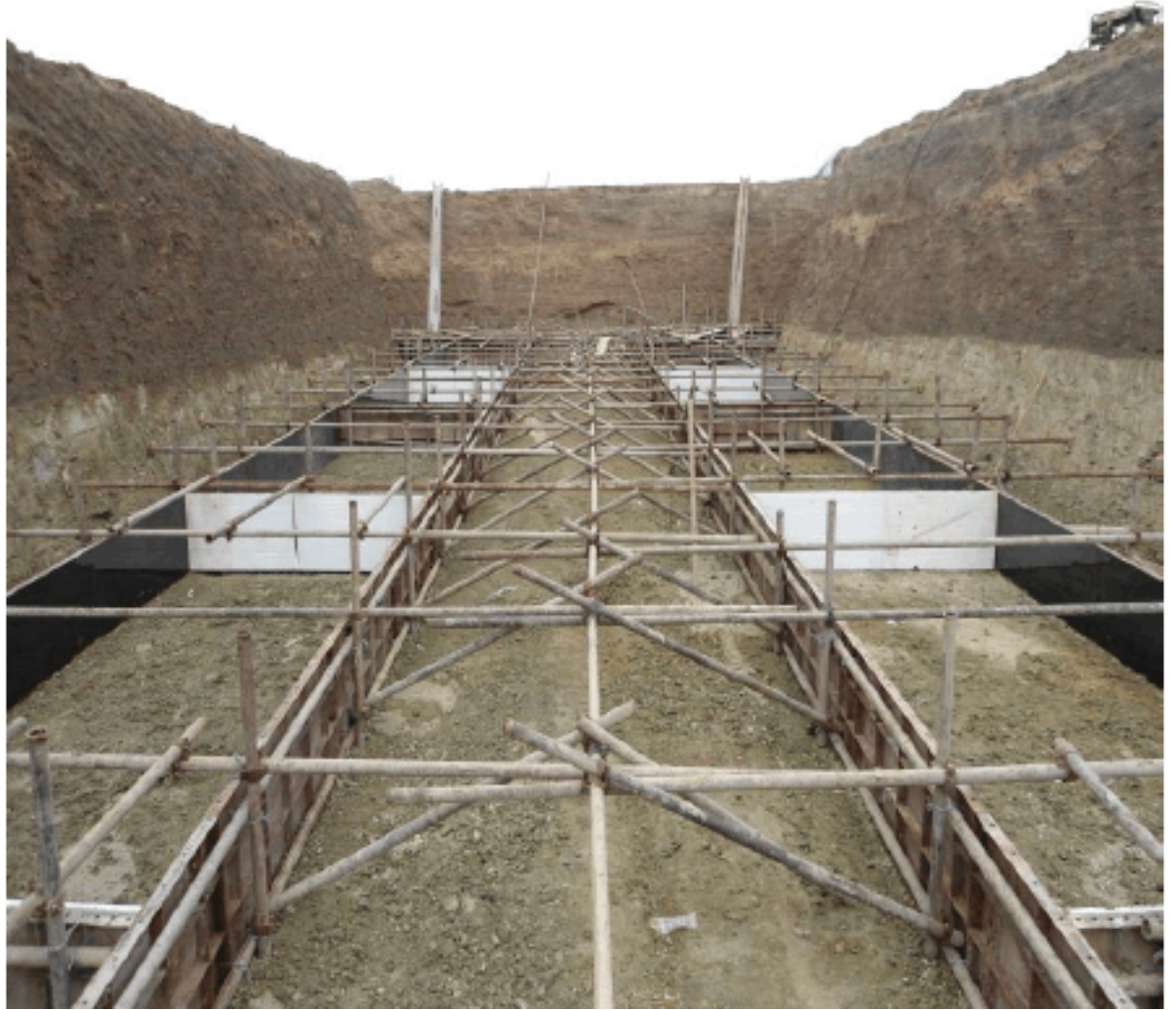
模板安装允许偏差
