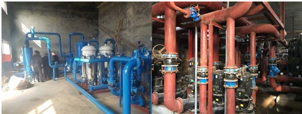
照 5 山东省平原县砂岩热储地热尾水回灌照 6 山东省禹城市砂岩热储地热尾水回灌
