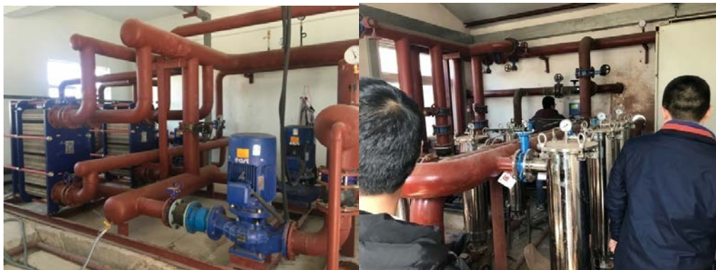
照 3 山东省博兴县砂岩热储地热尾水回灌照 4 天津市砂岩热储地热尾水回灌
