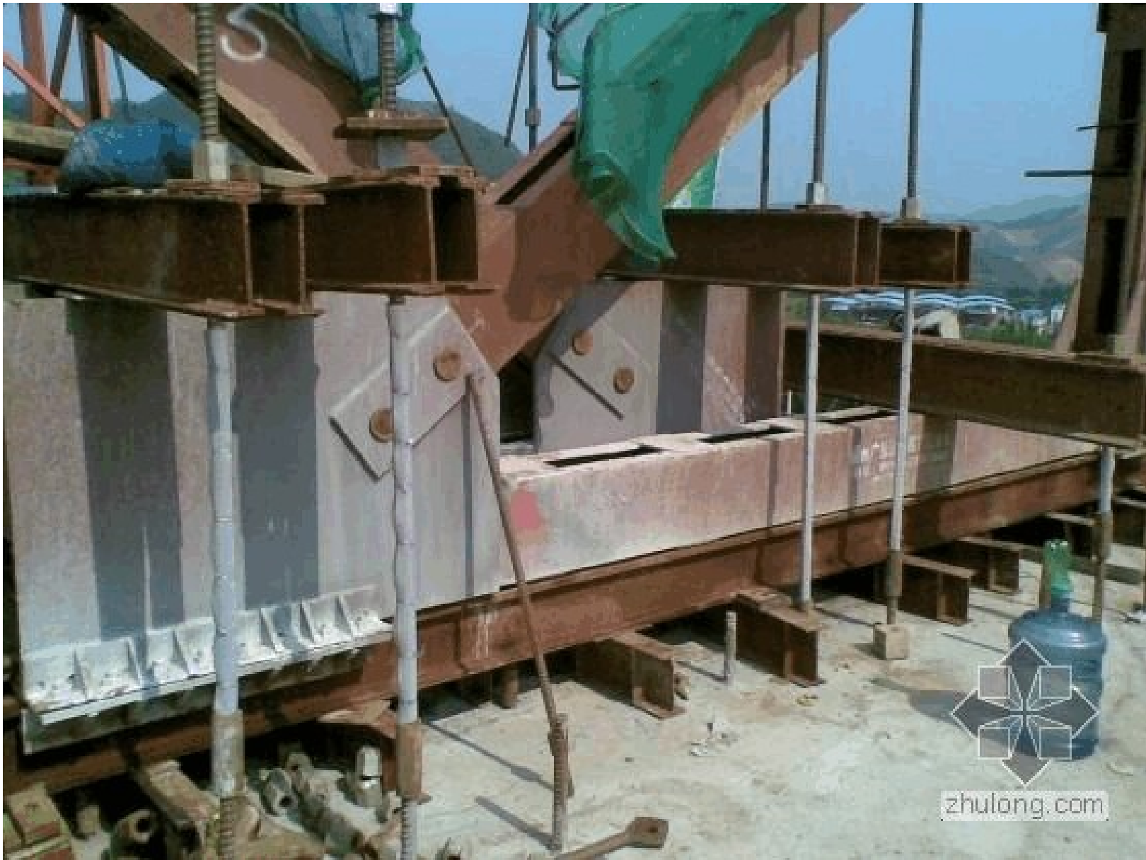
0#块上挂篮，很明显的内错拼装，到1#块我们也没有再将挂篮移位
