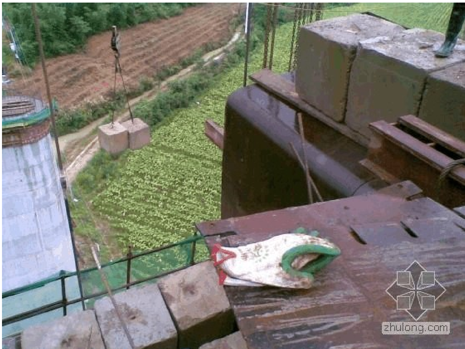
挂篮预压，预压要求达到设计重量的120%。主要看挂篮的弹性和非弹性变形量预压完毕后又是调挂篮、钢筋绑扎、混凝土浇筑、养护、张拉、压浆一个循环就说说一些块段不同，需要大家注意的
