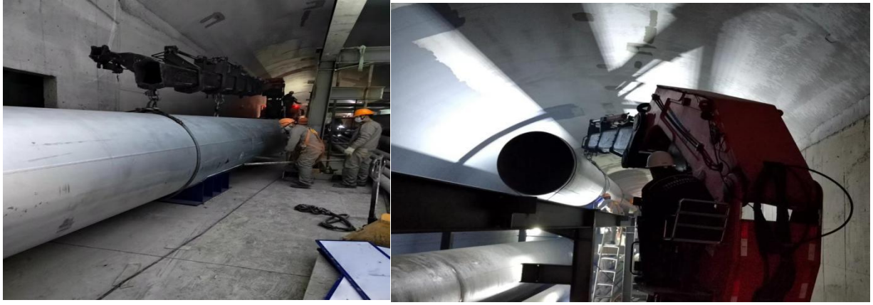
图 5.2.5-2 二层北侧 DN1400 管托安装
