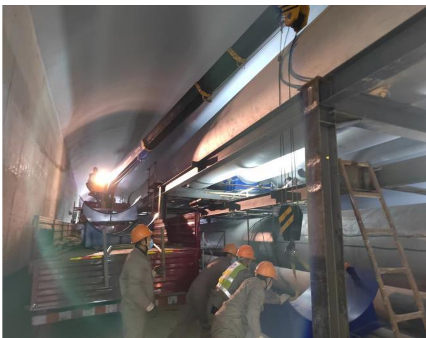
图 5.2.5-1 管托提前放在指定位置
