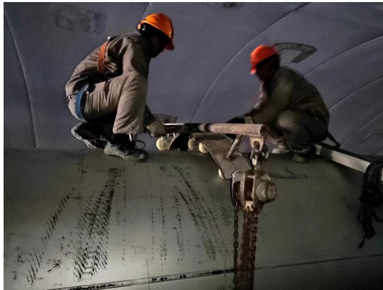
图 5.2.5-5 人员在管道上方把管托推至设计位置就位
