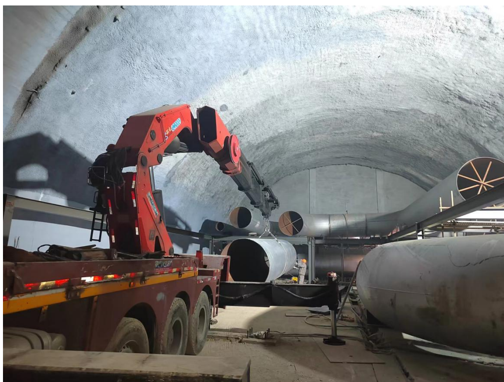
图 5.2.6-2 洞内膨胀弯先东侧后西侧吊安
