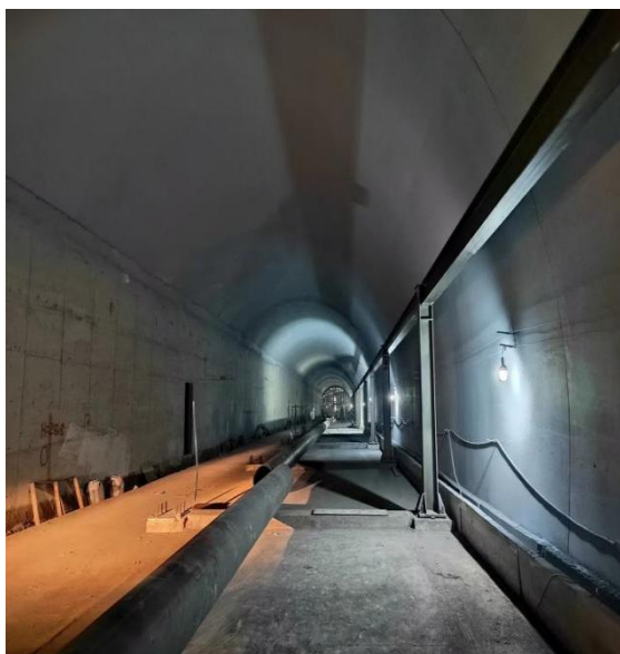
图 5.2.3-3 北侧钢结构安装
