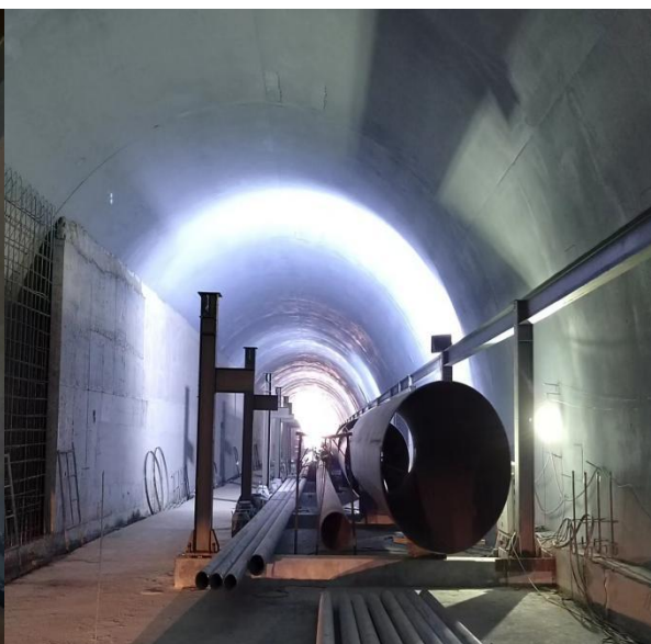
图 5.2.3-4 一层管道敷设及南侧钢结构安装
