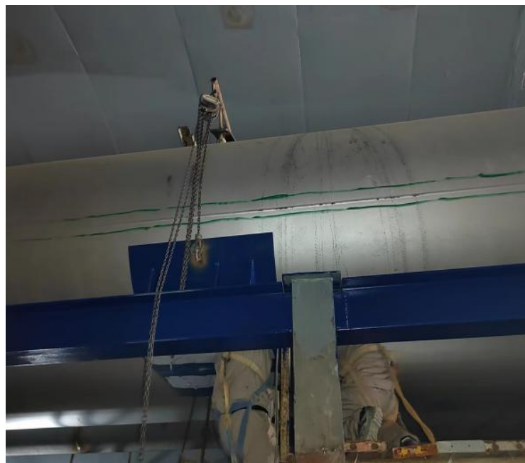
图 5.2.5-3 利用自制工装运吊管托
